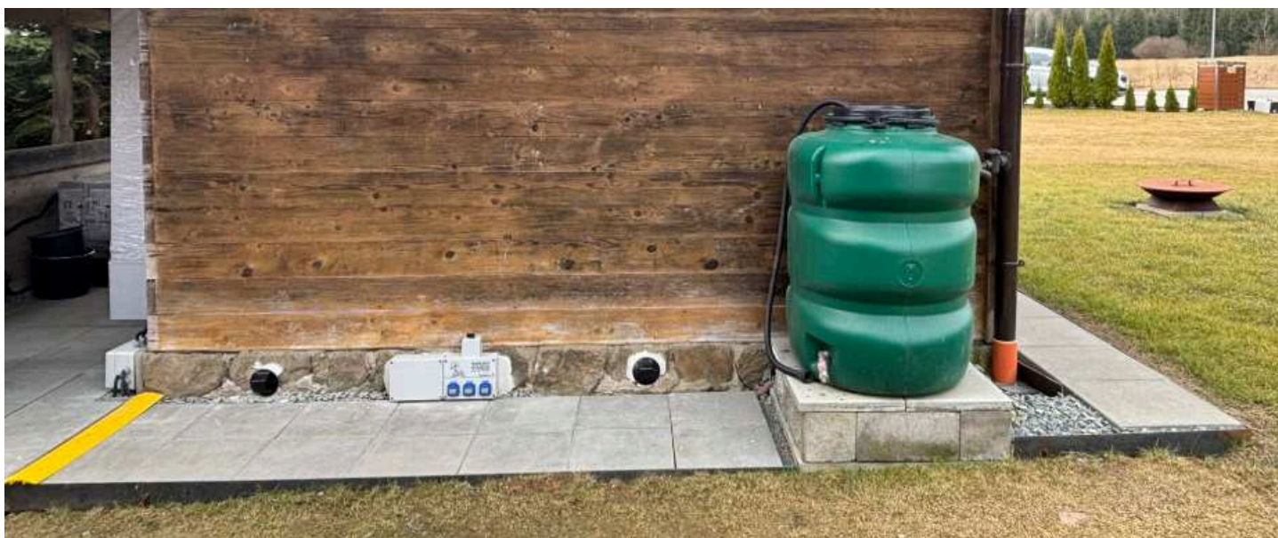
Pohled na zásuvky u východní stěny zahradní chatky
