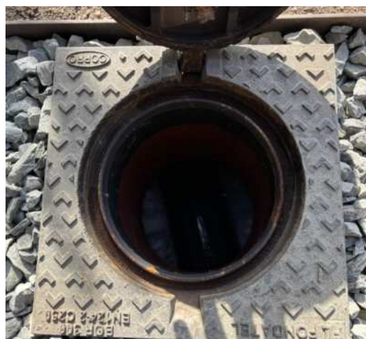
Detailní pohled na otevřenou šachtu odpadních vod
