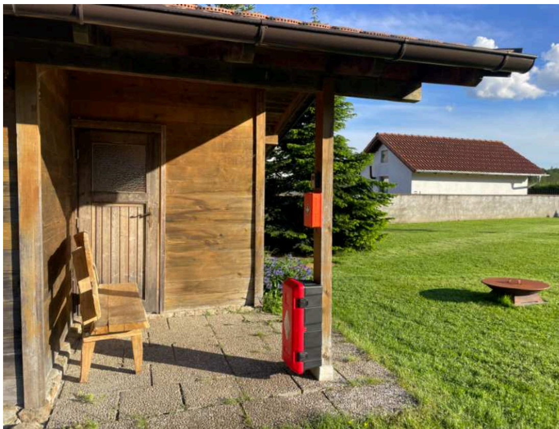
Pohled na sloupek, na kterém je umístěn klíčový trezor, lékárnička a hasicí přístroj
