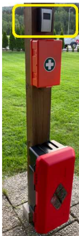
Klíčový trezor připevněný na sloupku v u vstupu do chatky
