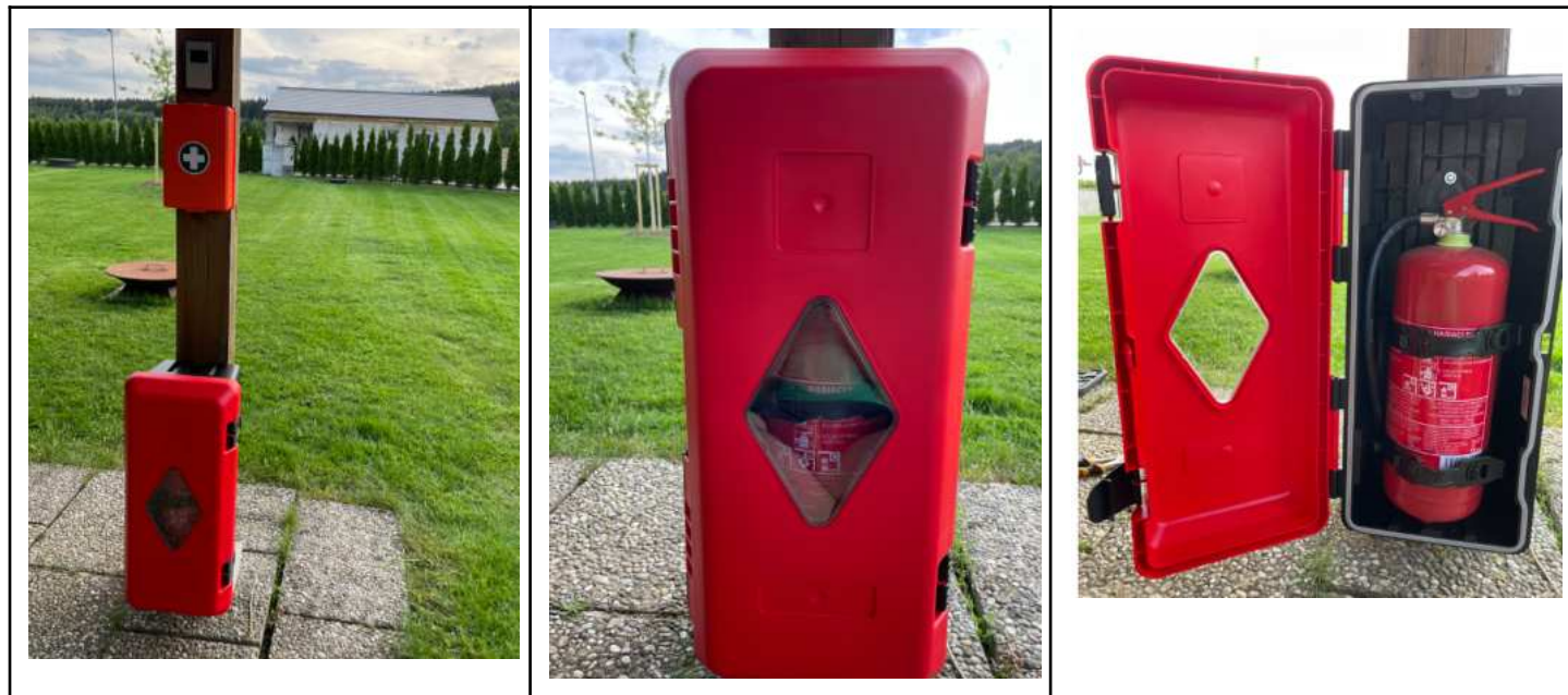
Hasicí přístroj a jeho umístění v ochranném plastovém krytu před vstupem do zahradní chatky
